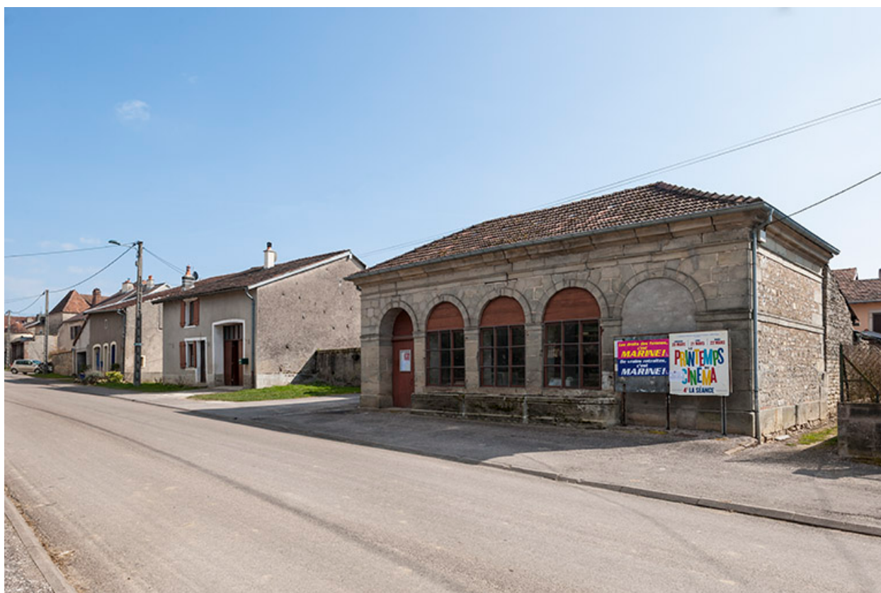
Ancien lavoir, rue Antoine Lumière.
