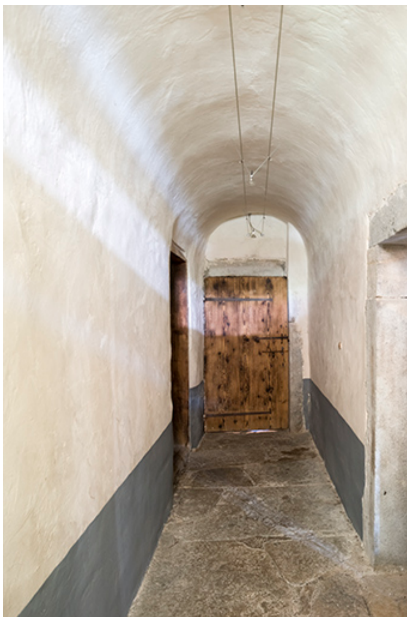
Couloir voûté (côté sud).
