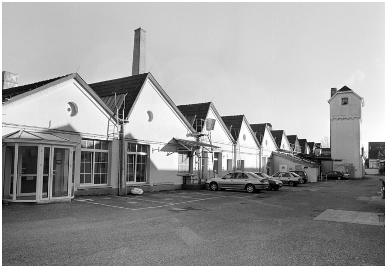
Pignons ouest de l'atelier de fabrication.
