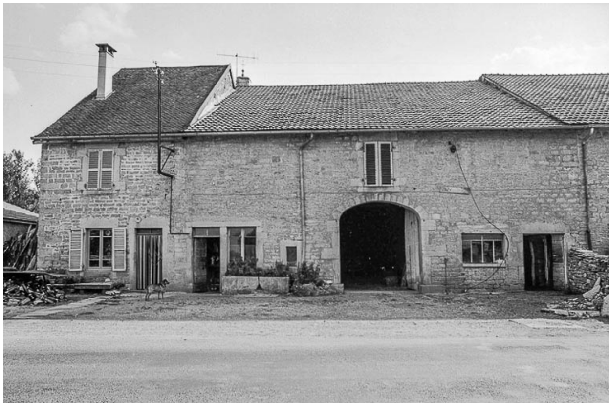
Ferme cadastrée A3 195 : façade antérieure.
