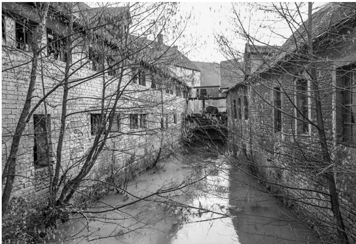
Bief de dérivation entre les ateliers en 1979.
