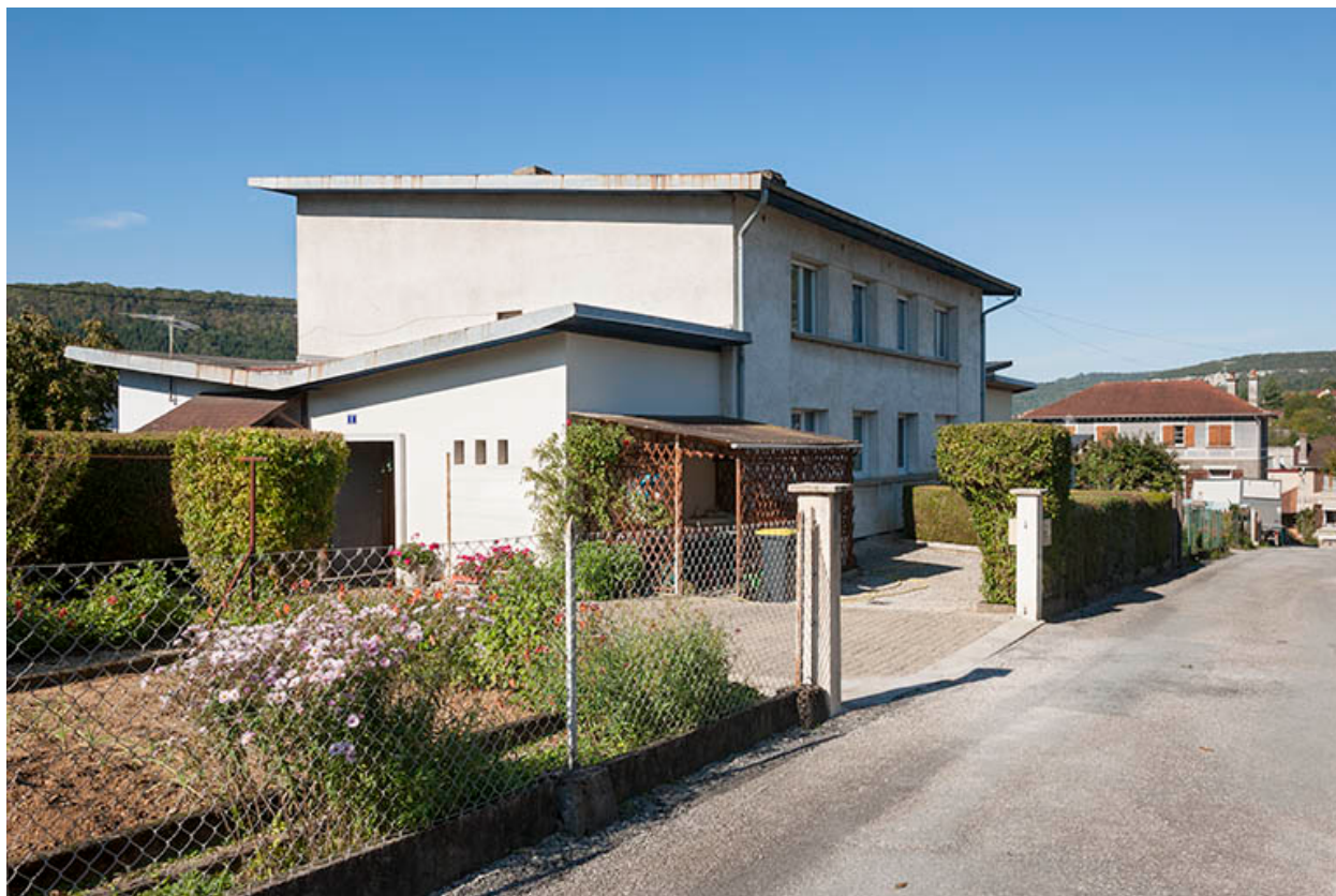
Maison à quatre logements (années 1950).
