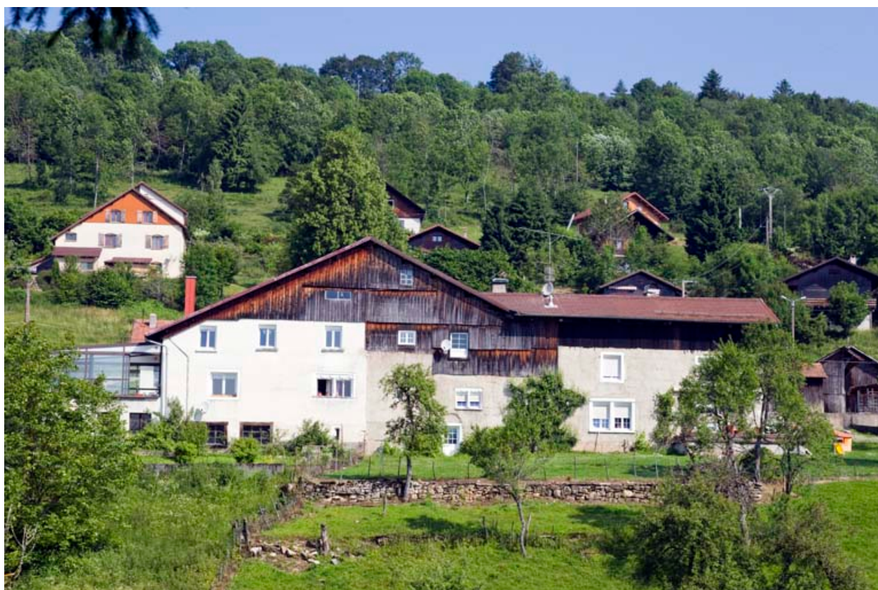
Façade latérale droite.
