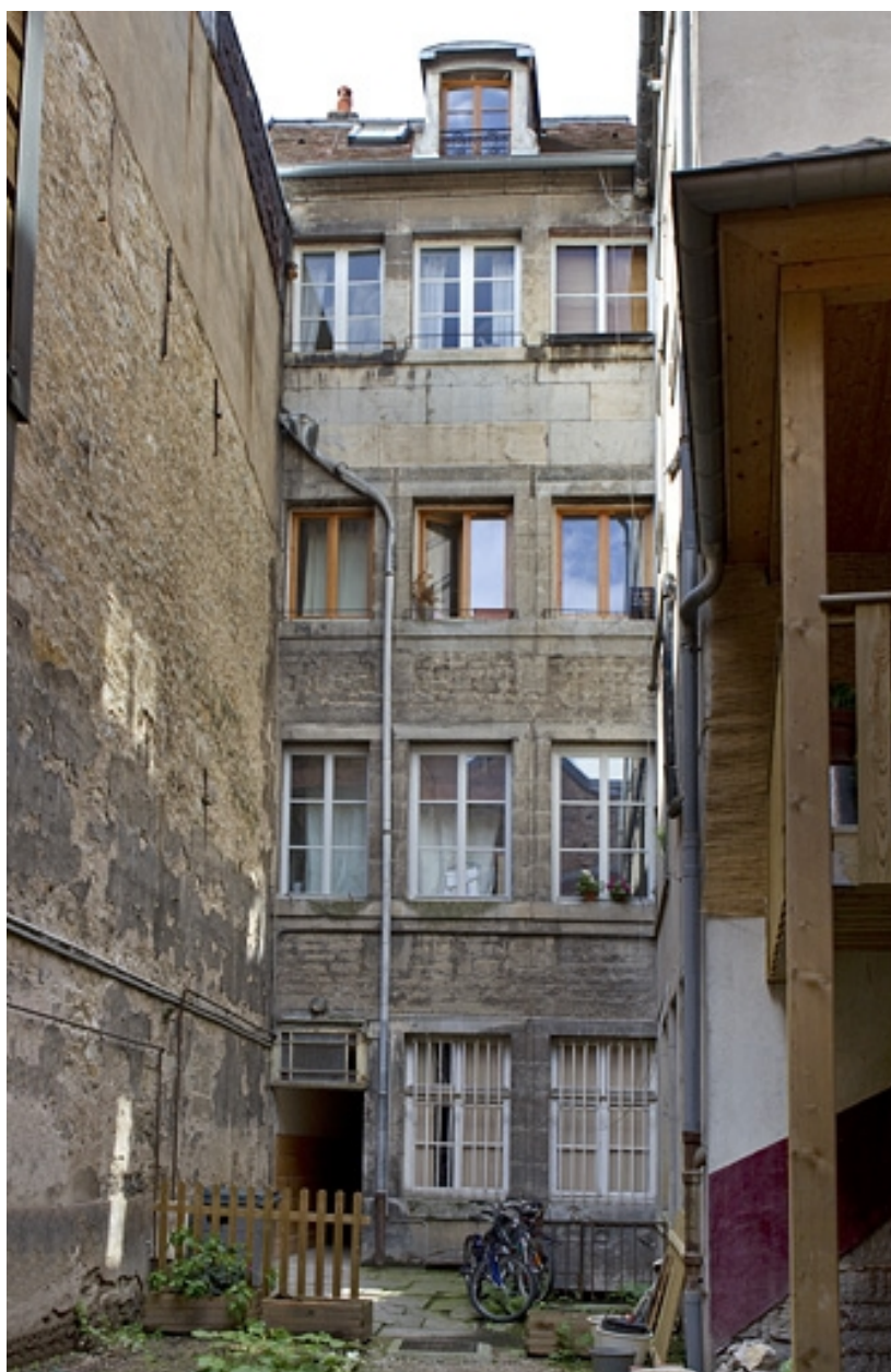
Logis principal, façade sur cour : vue d'ensemble.
