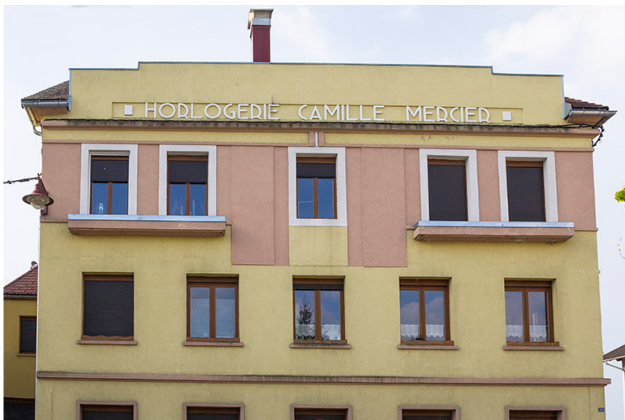
Immeuble : façade antérieure (étages).
