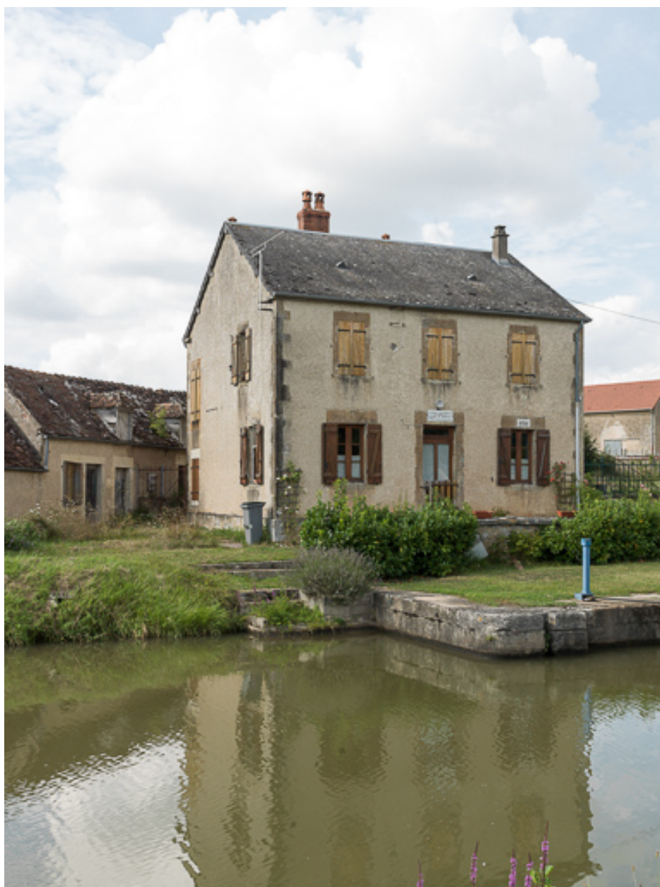
Vue de la maison éclusière.
