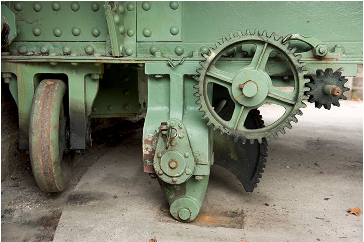
Détail du système de calage du pont.
