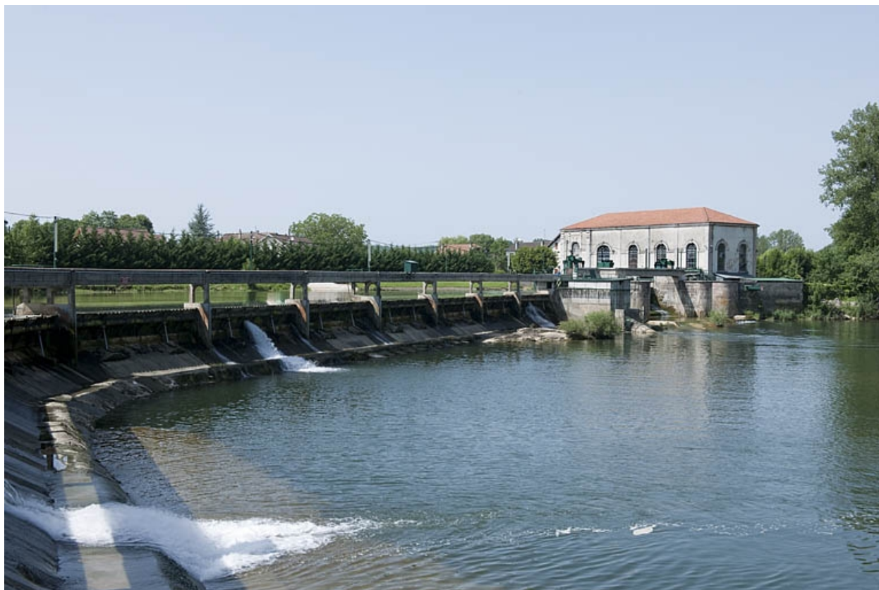
Centrale hydroélectrique de Mathay.
