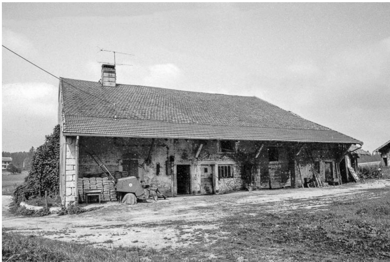
Façade latérale droite.
