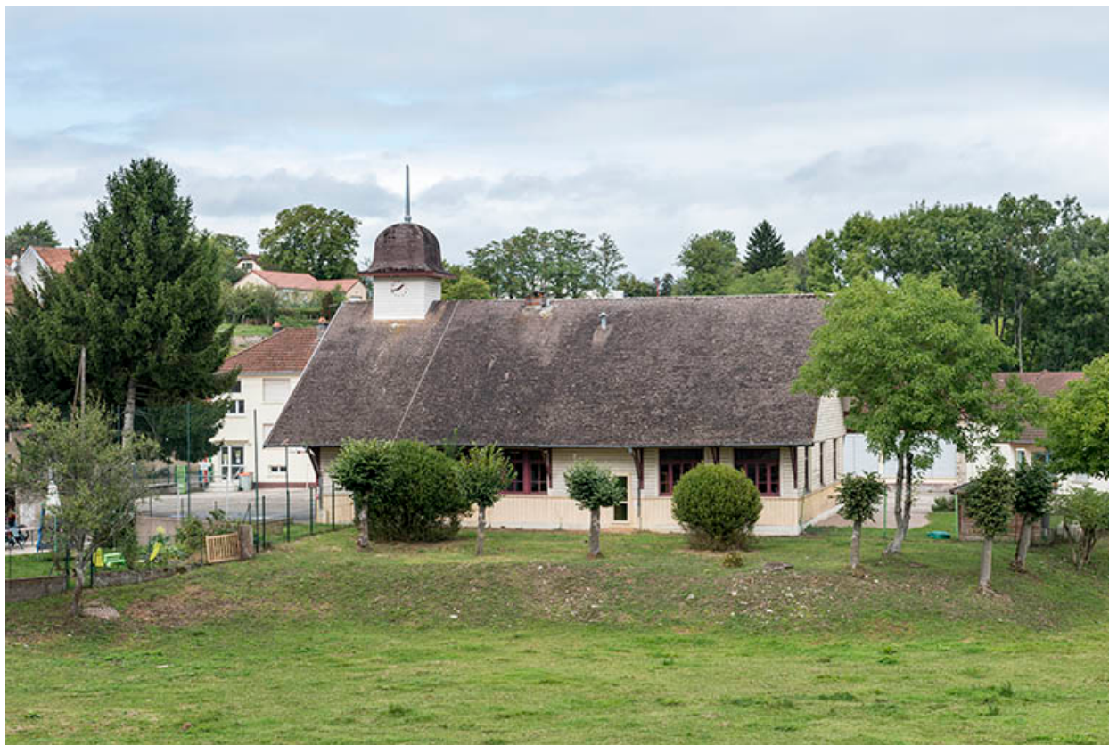
Vue depuis le pont.
