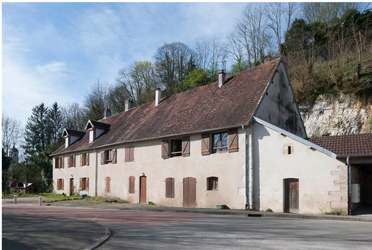
Logement ouvrier (11-13 route d'Emagny).
