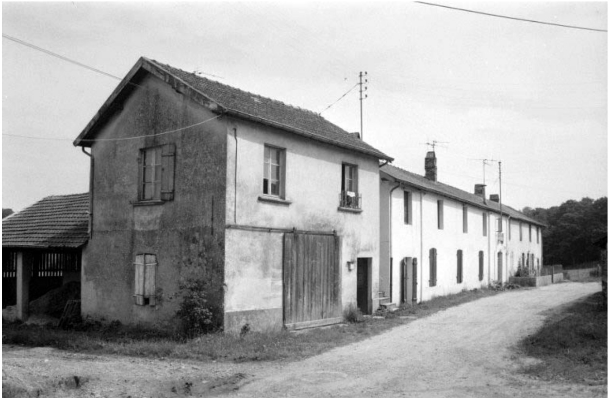
Logements d'ouvriers (C) et (D).
