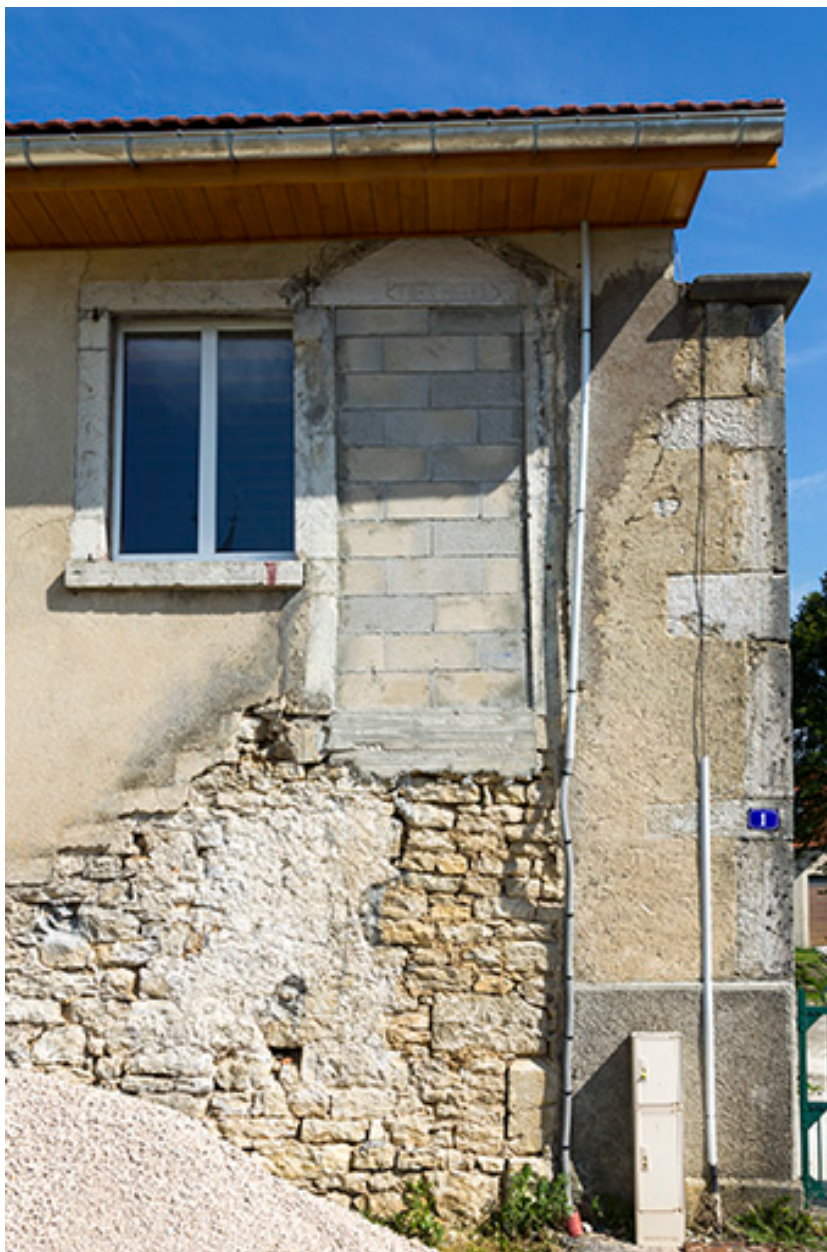
Façade latérale gauche : porte murée à l'étage.
