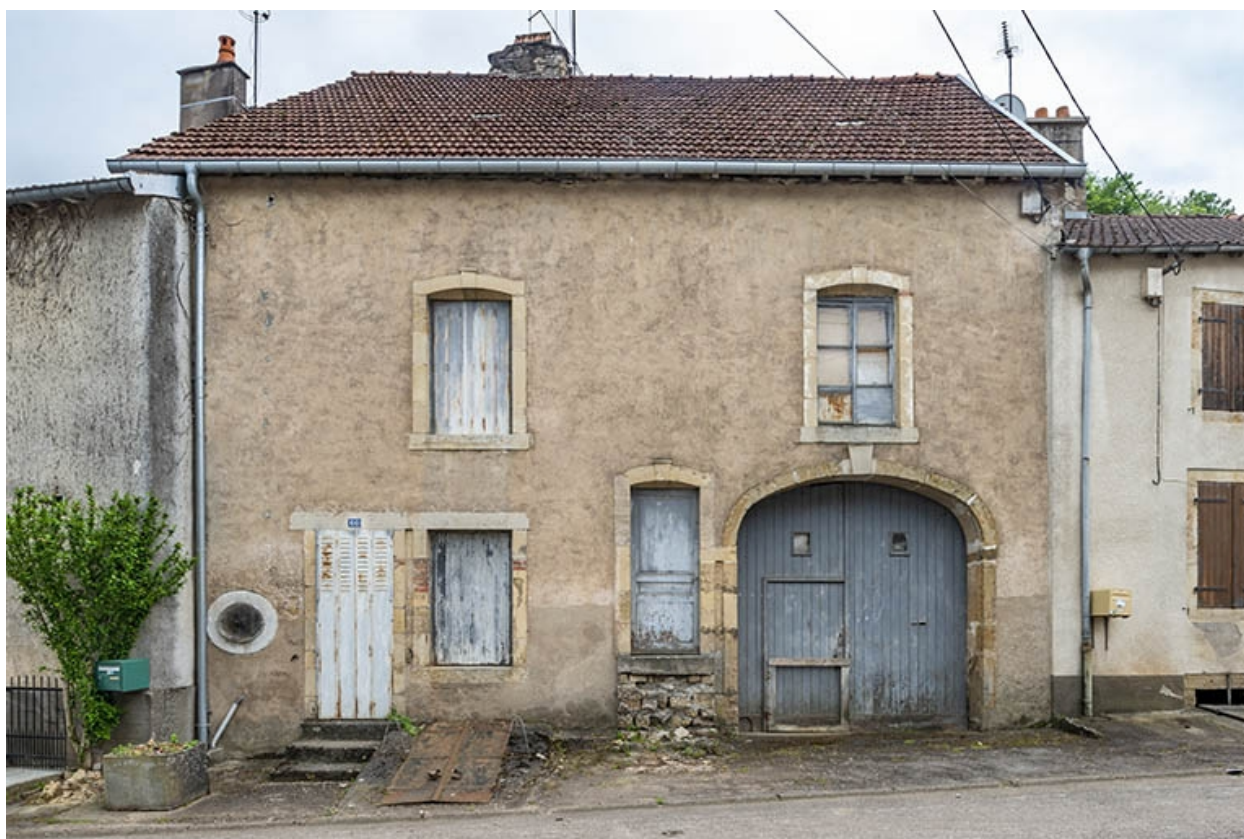
Rue Thiers, maison au n° 60.
