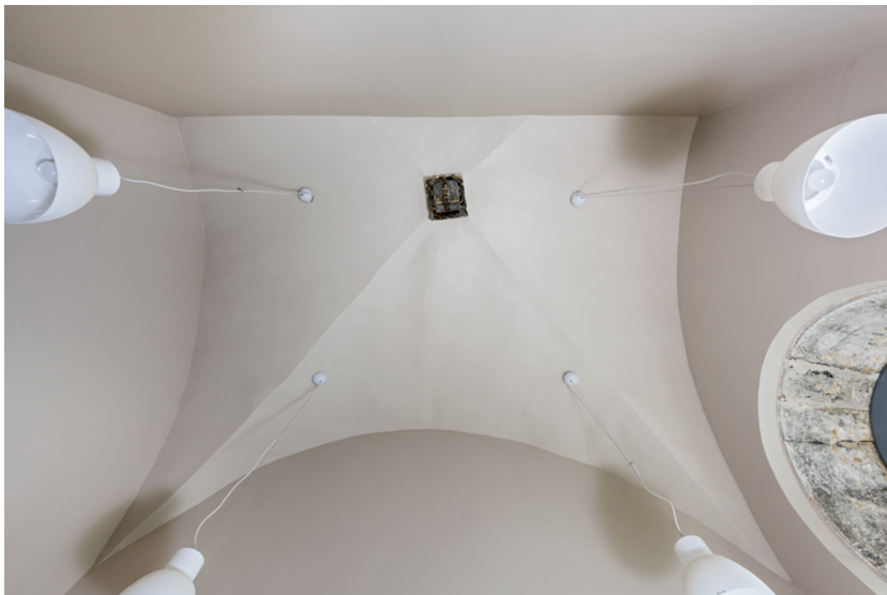
Ancienne chapelle : voûte et blason.
