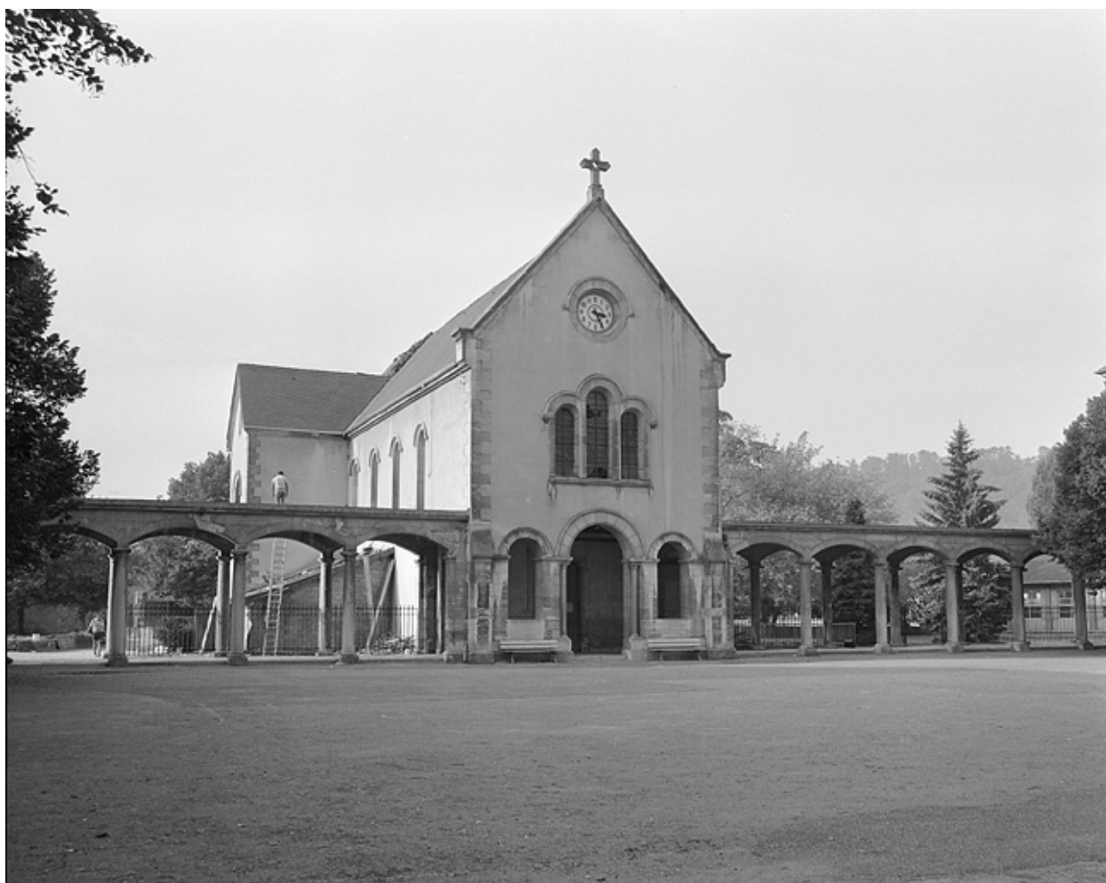
Façade antérieure de la chapelle et portique.
