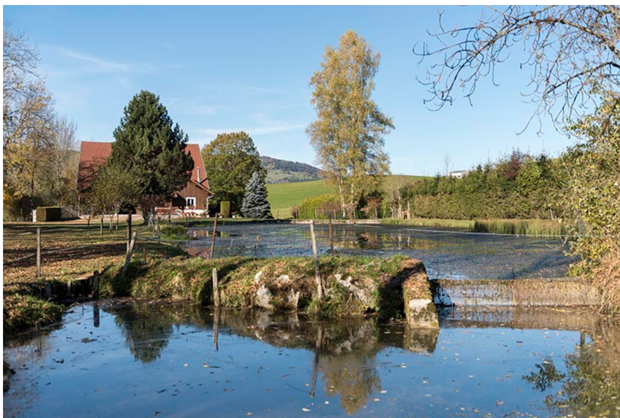
Le bassin de retenue.
