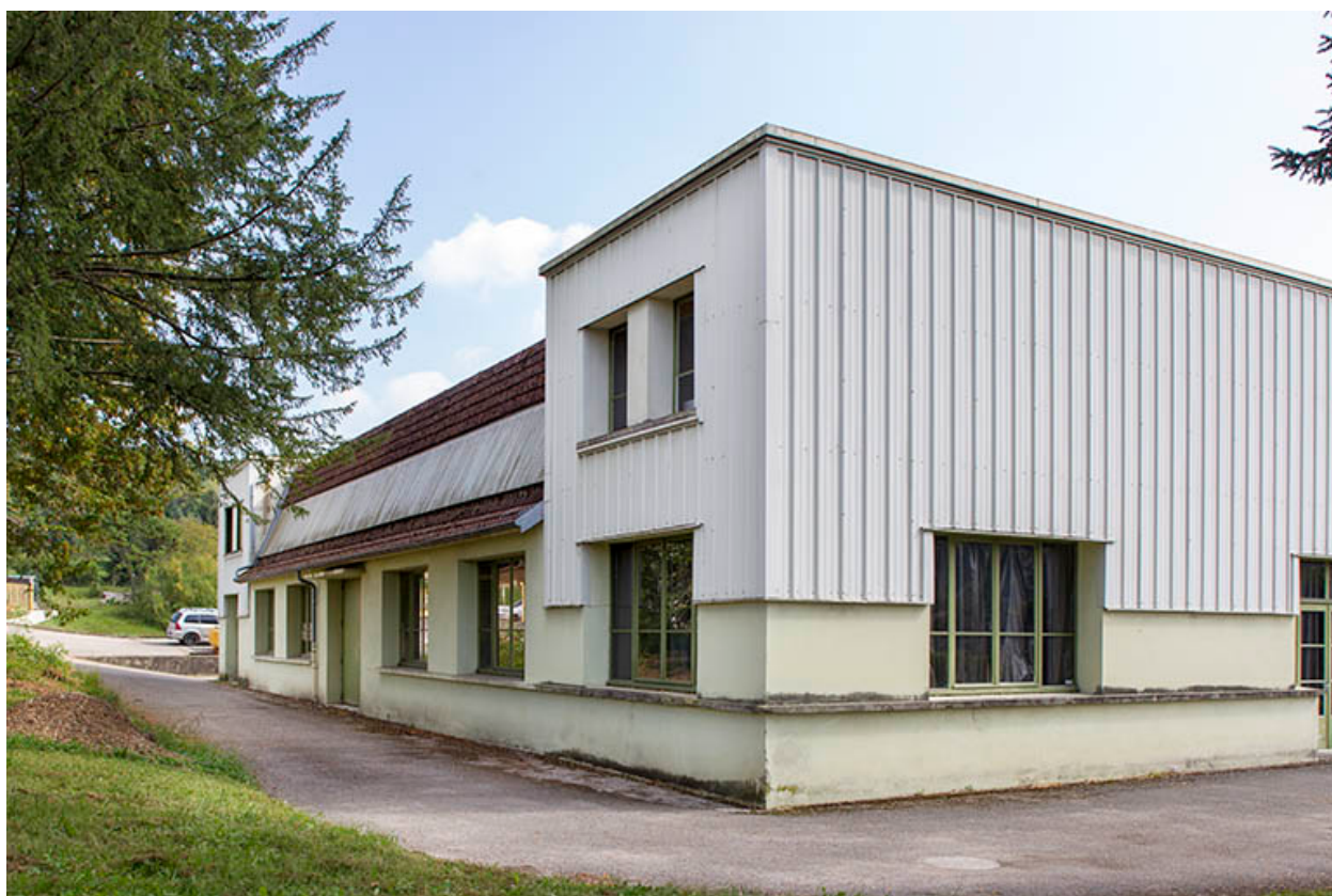
Atelier construction : façade postérieure.
