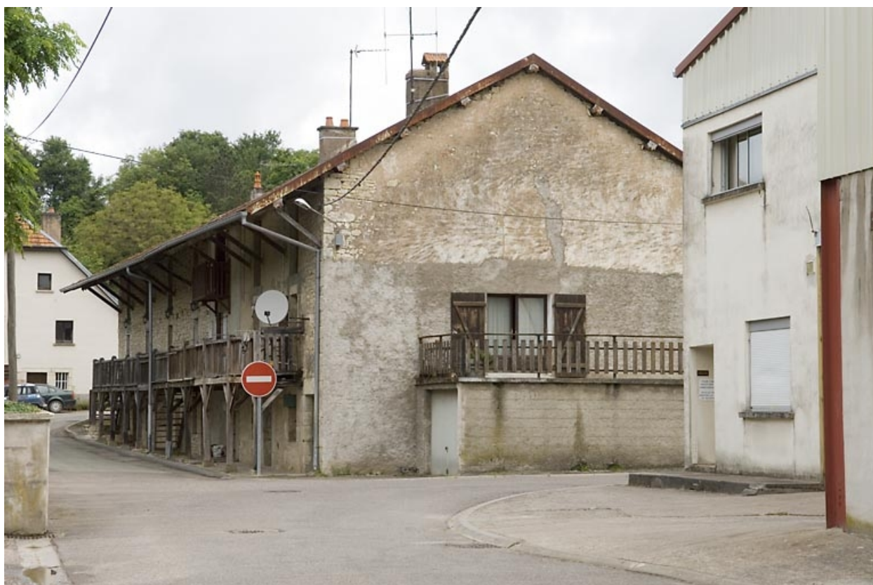
Logement ouvrier vu depuis le sud.
