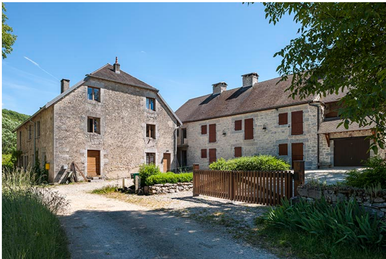
Logements d'ouvriers. Vue d'ensemble depuis le nord-ouest.
