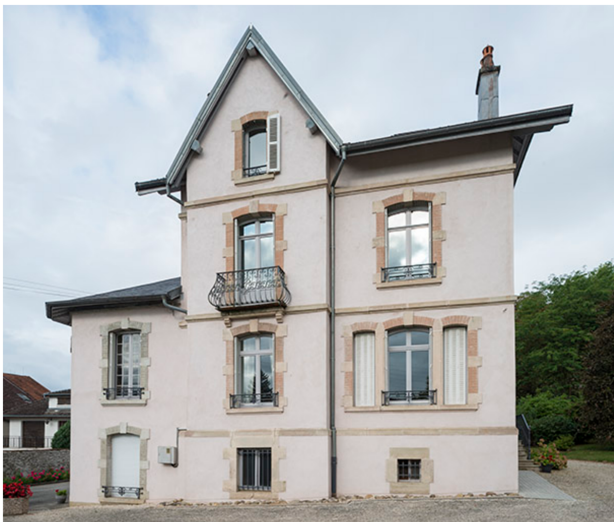
La façade principale.
