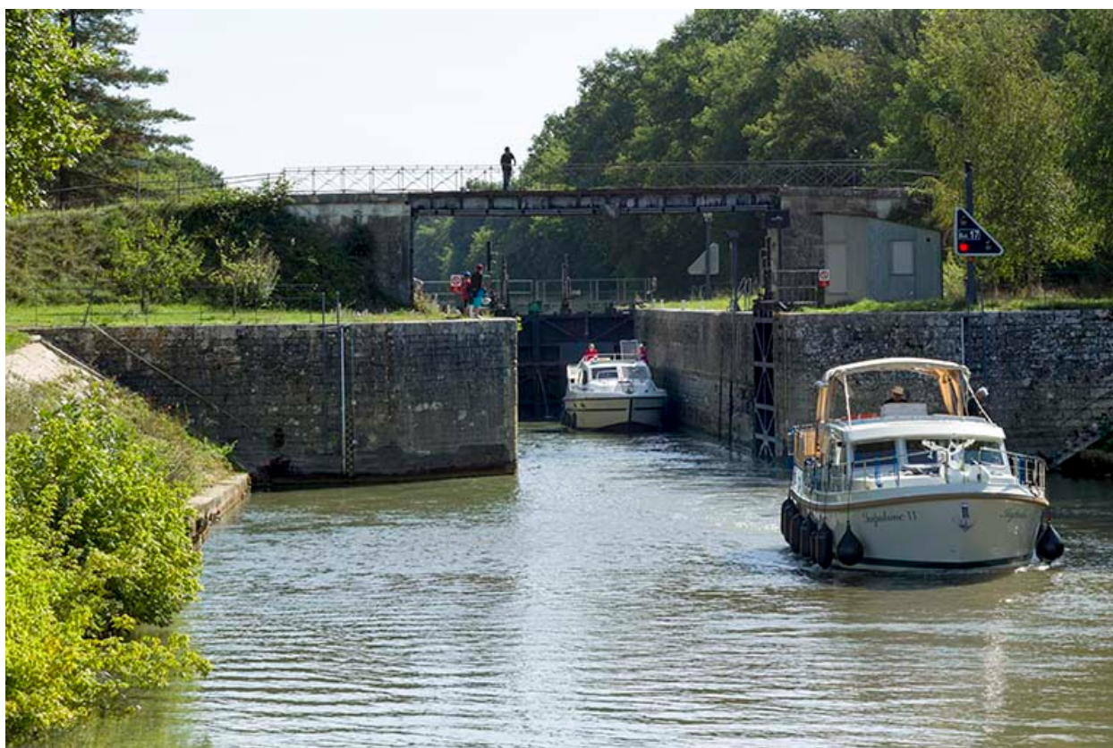
L'écluse depuis l'aval.
