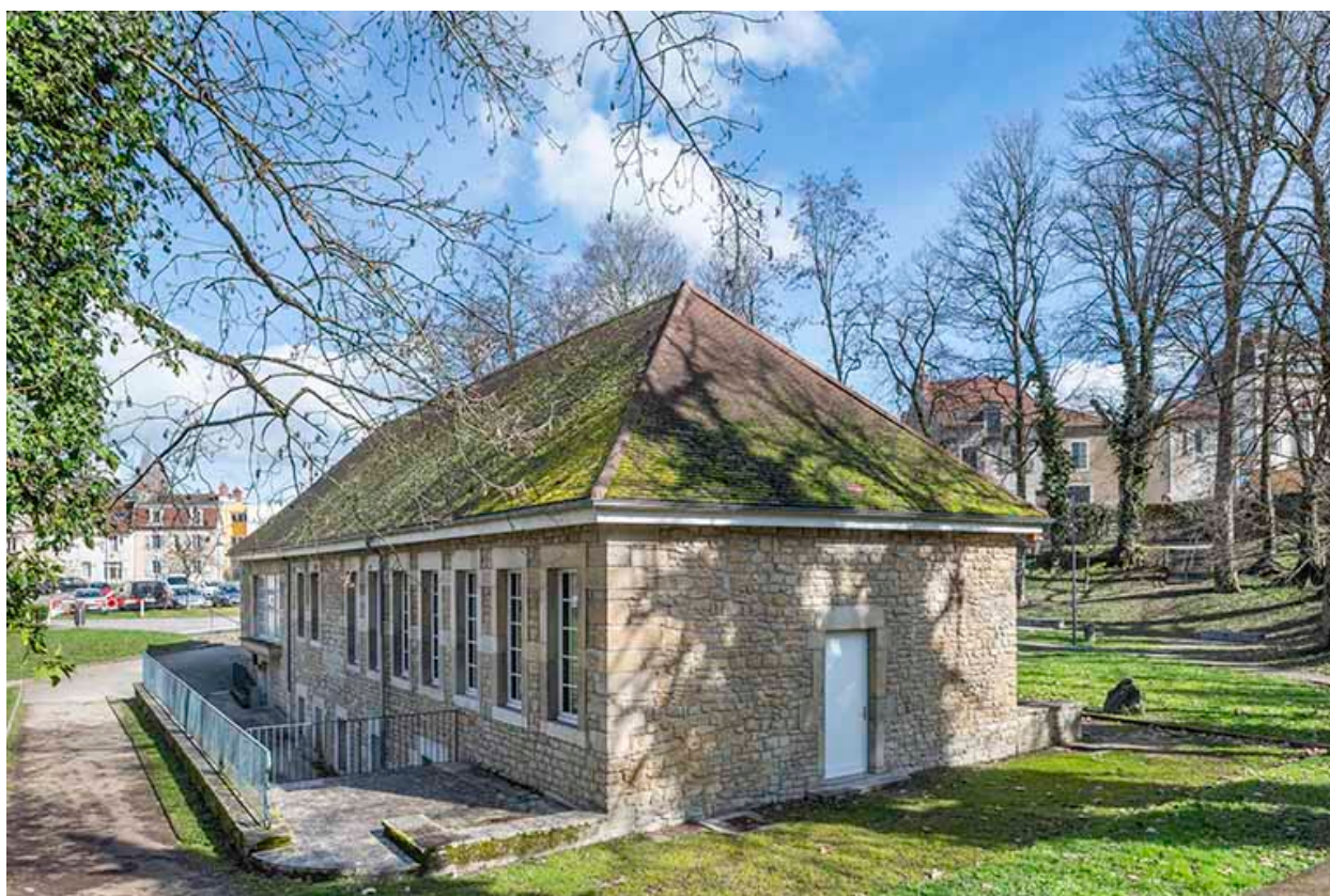
Vue depuis le sud-ouest.
