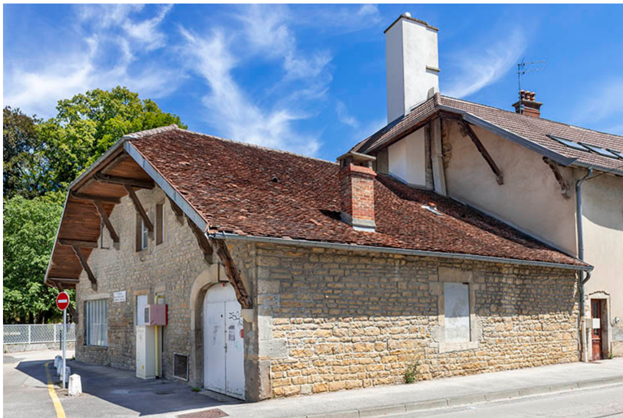
Vue depuis le sud-ouest.
