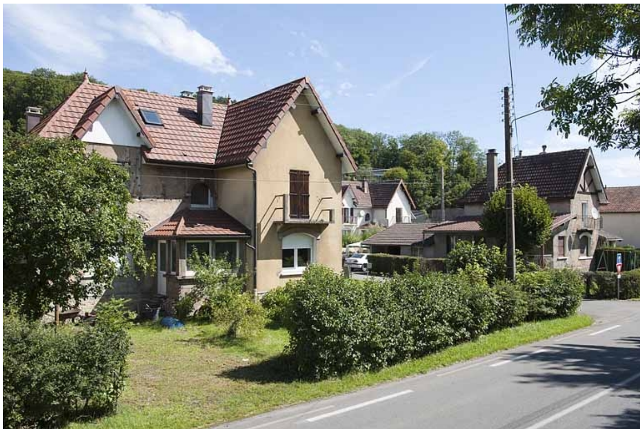
Maisons à deux logements de contremaître.
