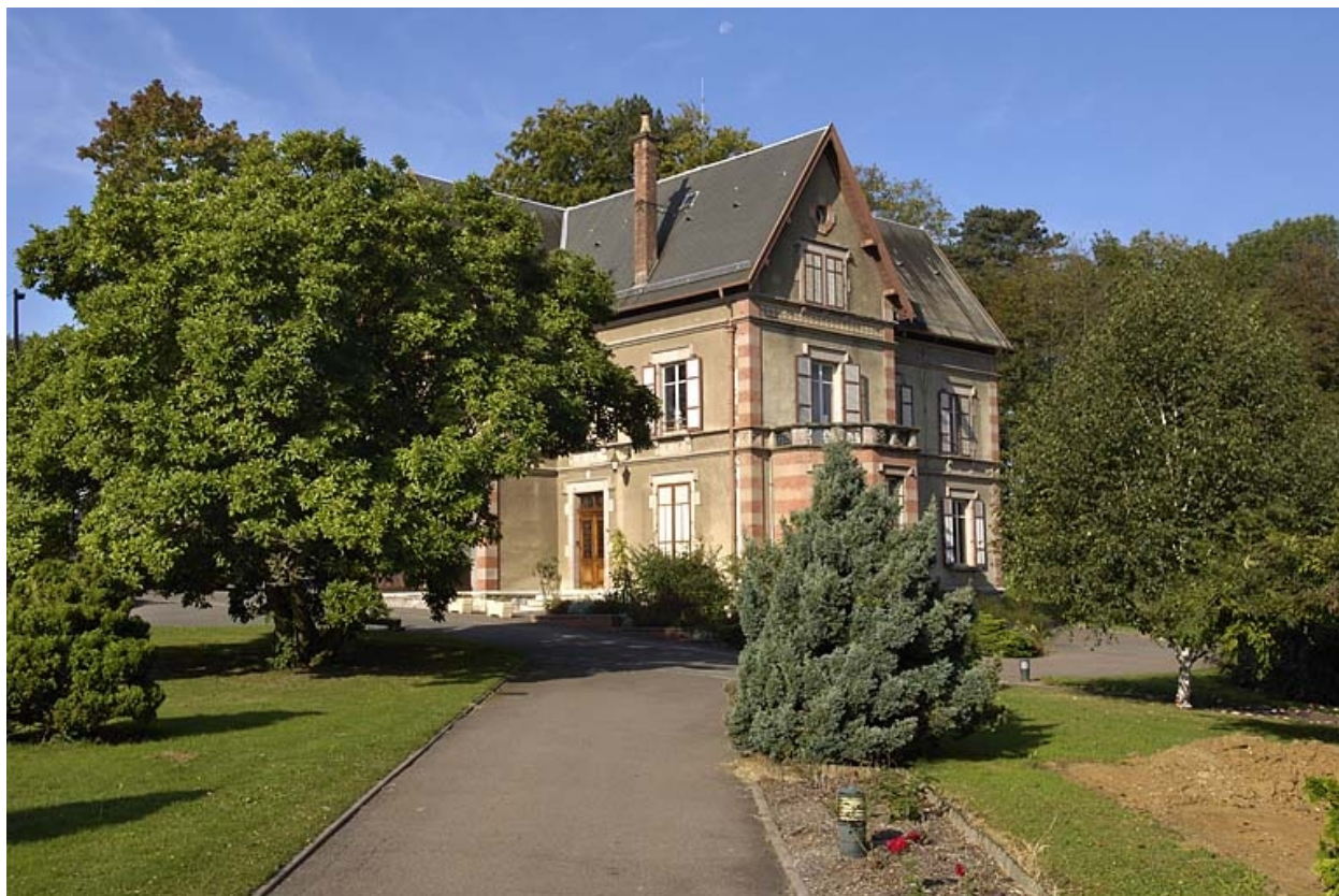
Vue de trois quarts depuis l'allée d'entrée.
