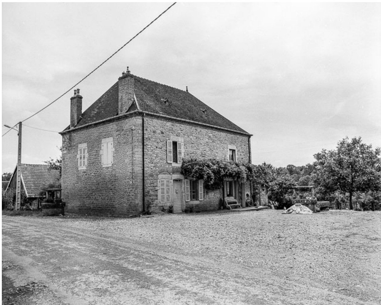
Le bâtiment d'habitation, façade antérieure.
