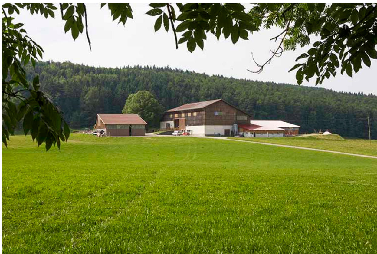
Vue d'ensemble rapprochée, depuis le nord.
