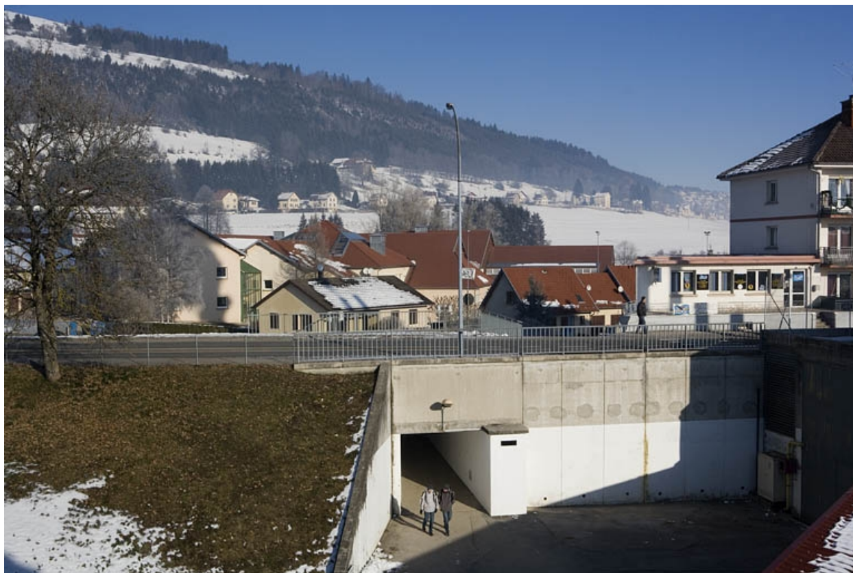
Site ancien : tunnel.
