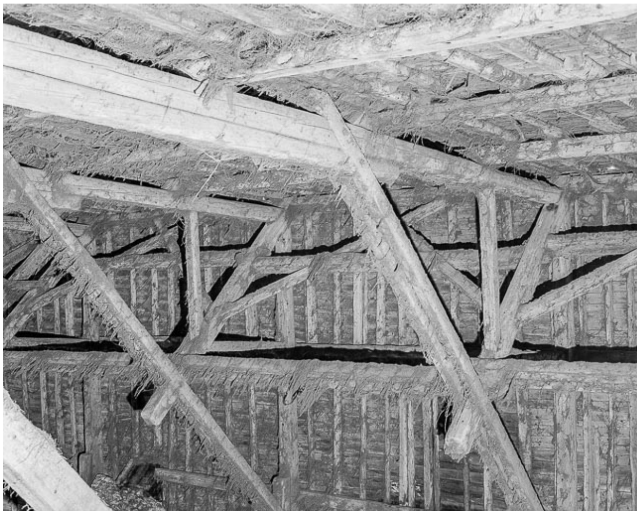
Charpente, partie supérieure.
