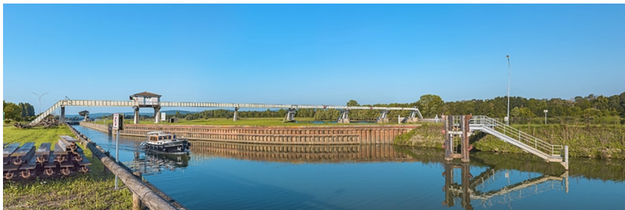
Le site d'écluse vu d'amont.
