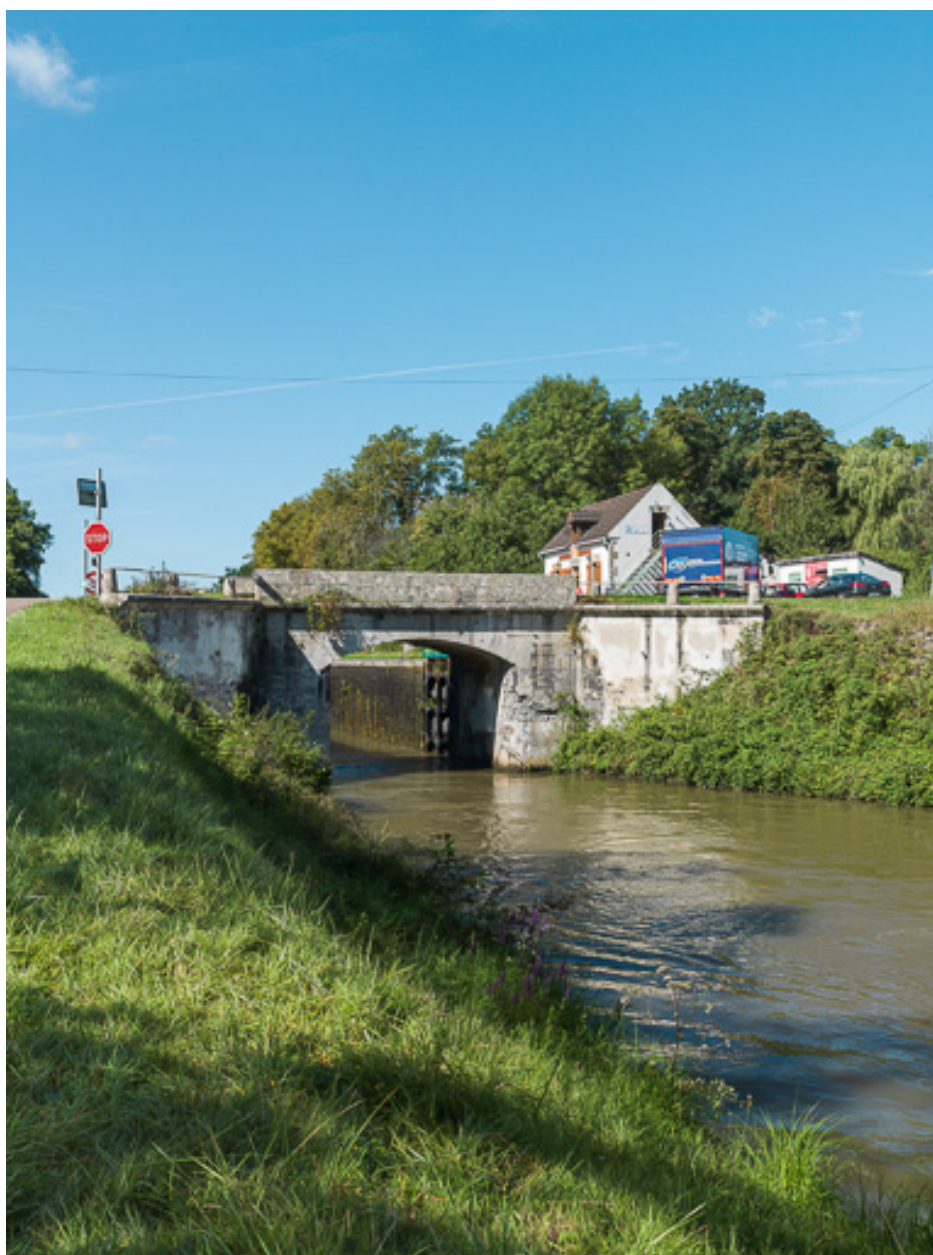
Vue d'ensemble du pont.
