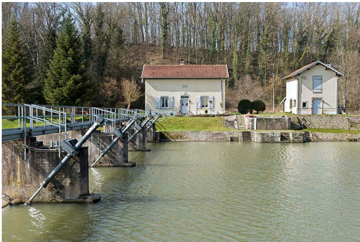
Le barrage et la maison du barragiste.
