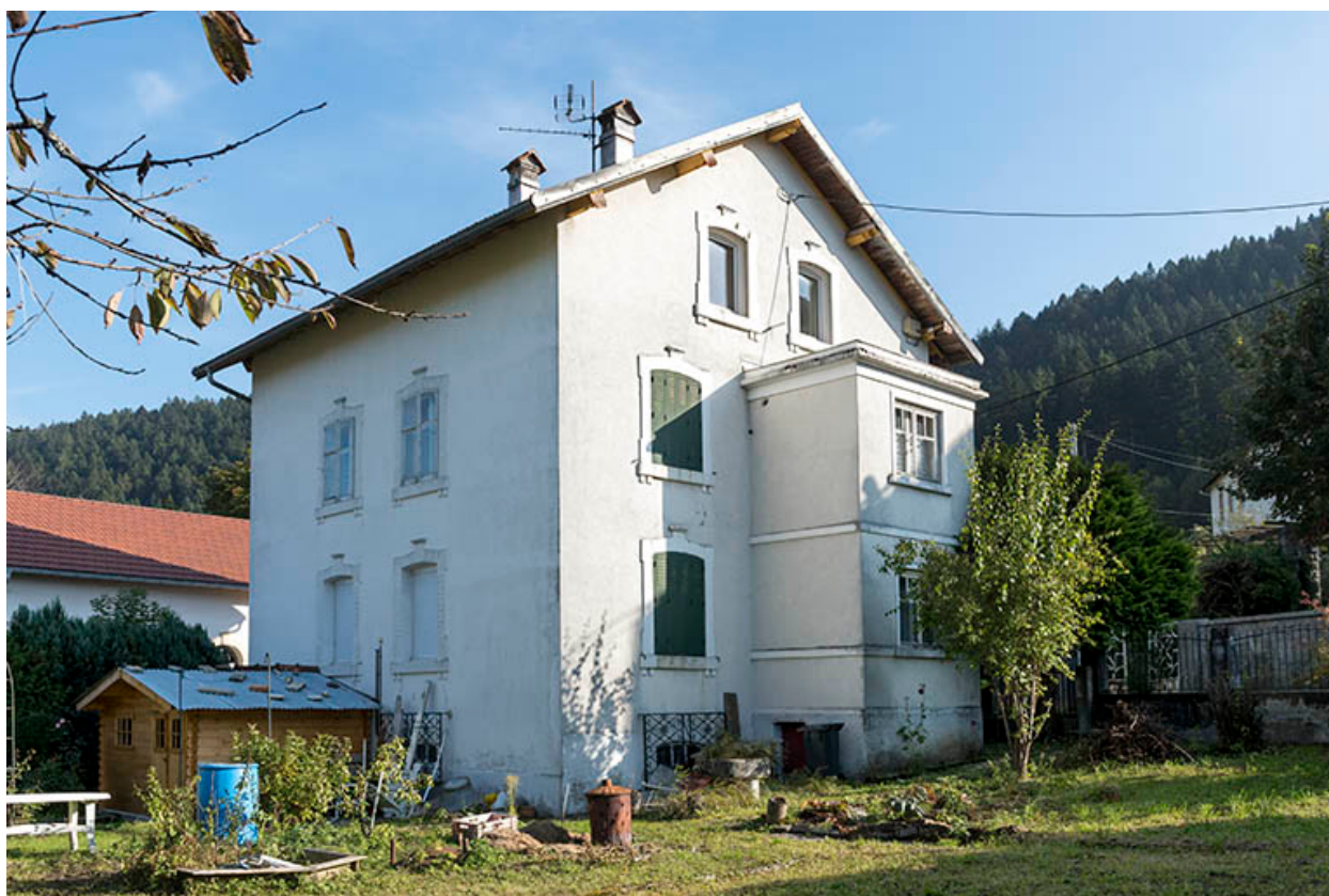
Façades postérieure et latérale gauche.
