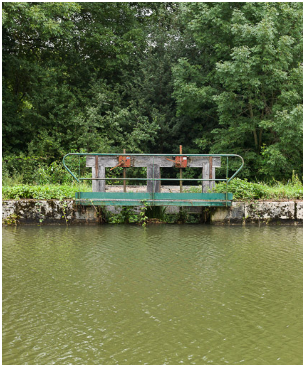
Vue du déversoir de fond.
