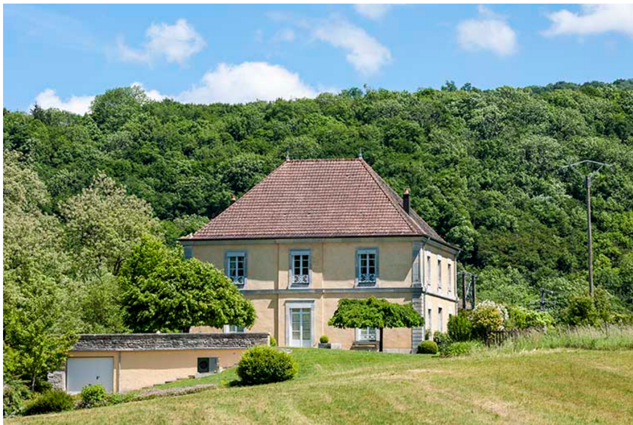
Logement patronal depuis l'ouest.
