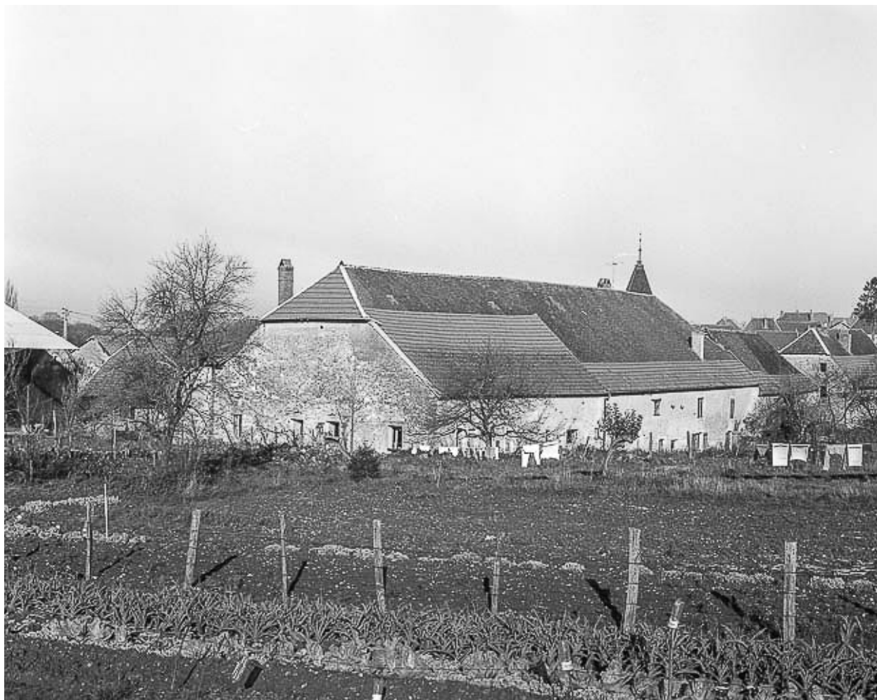
Façade postérieure : vue éloignée
