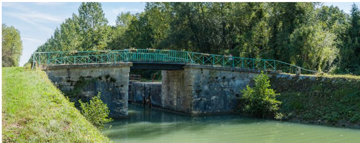
Le pont vu d'aval.
