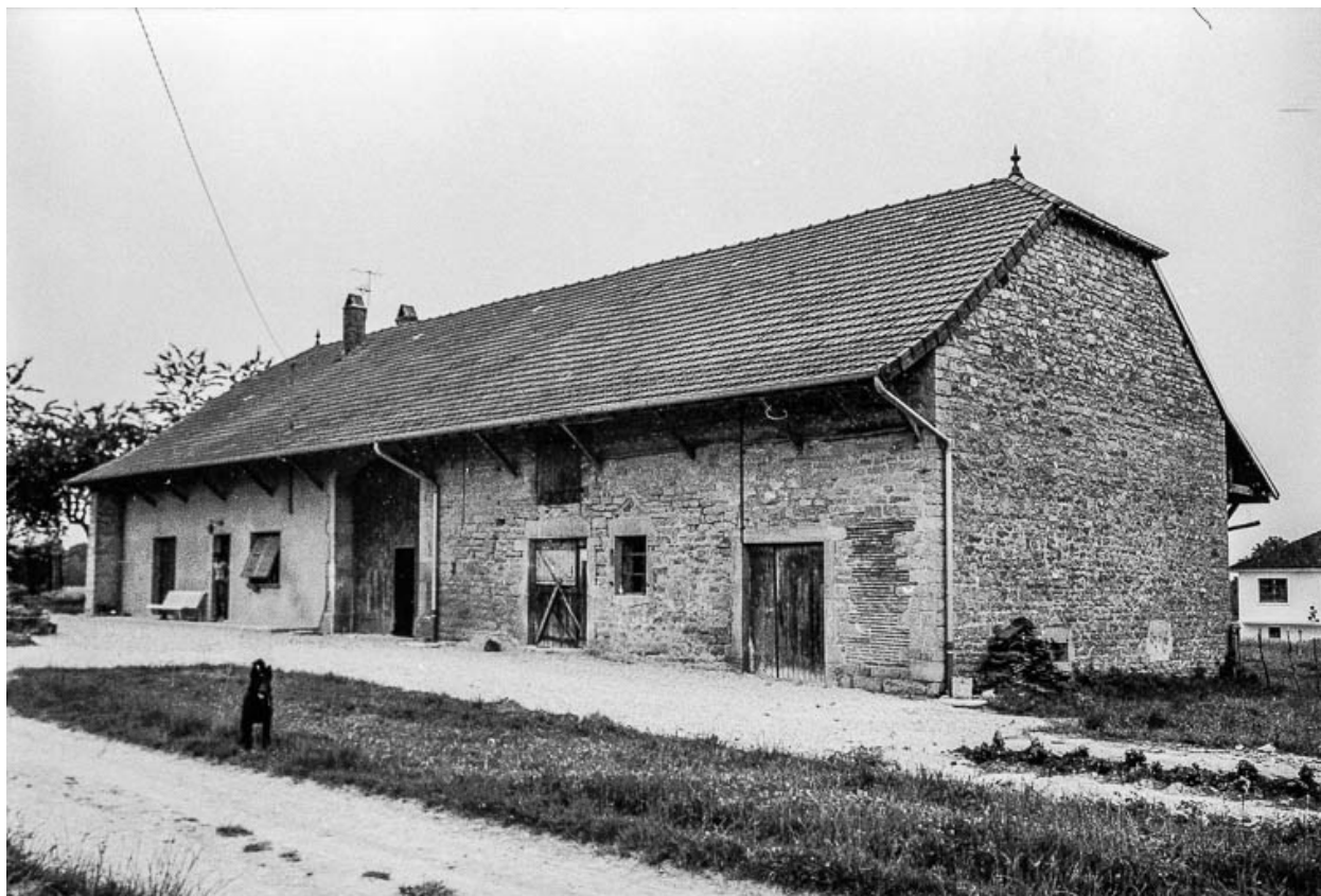
Ferme cadastrée 1969 AI 46 : façade antérieure.
