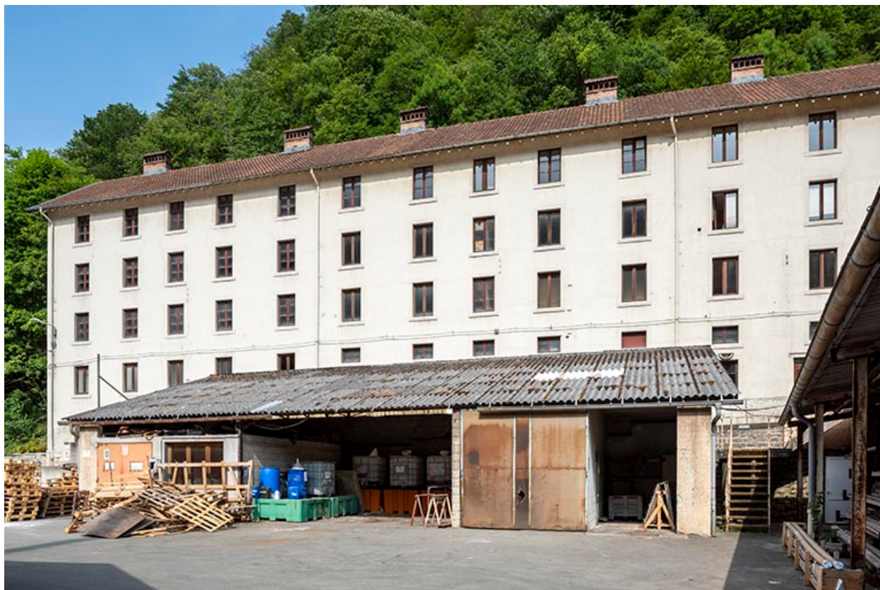
Bureau (façade postérieure) et entrepôt industriel.
