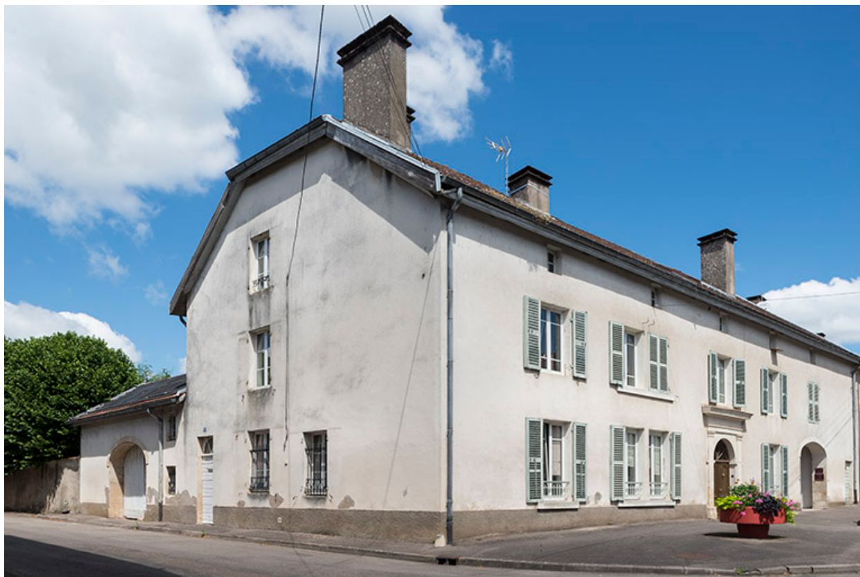
Le mur pignon sud.
