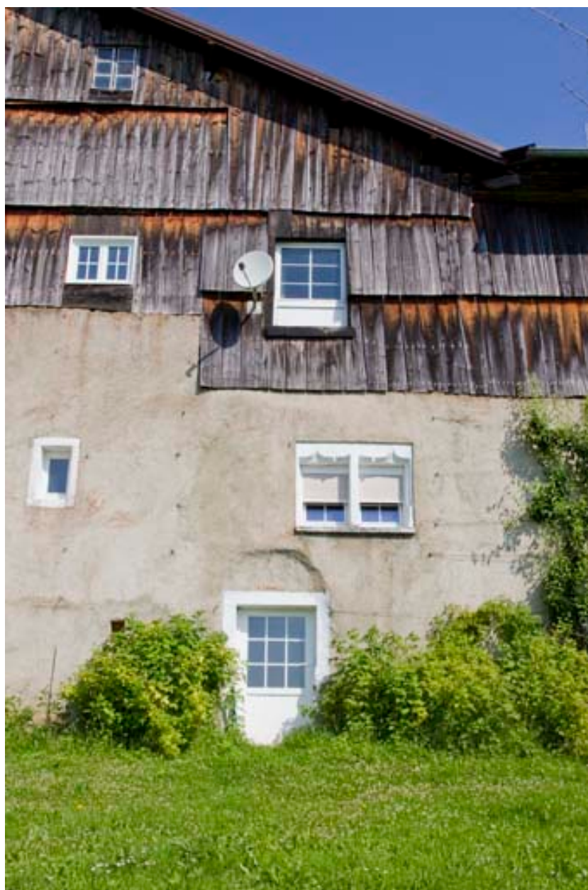
Façade latérale droite : baies.
