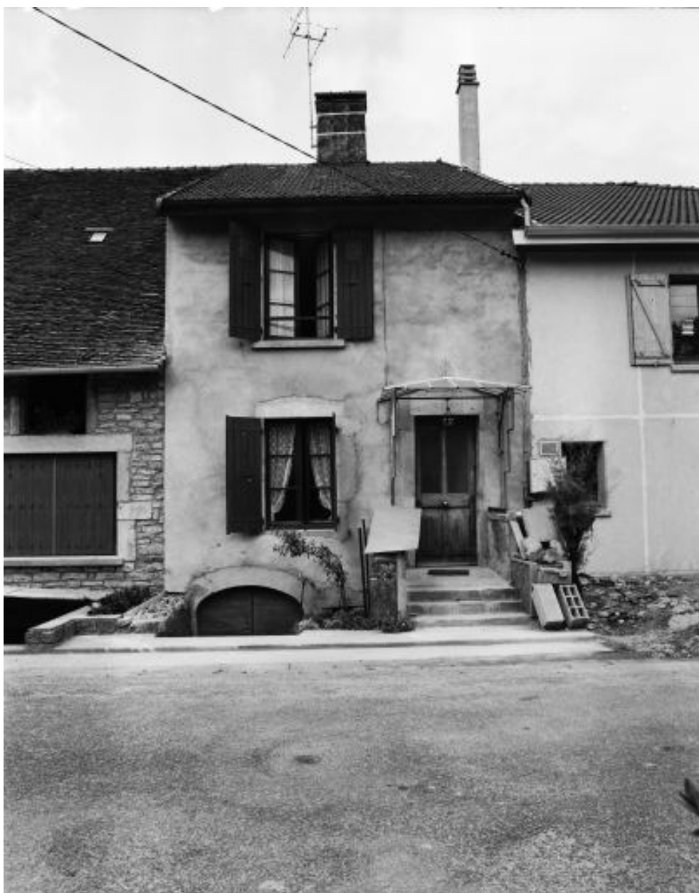
Ferme située rue Roche : façade antérieure.
