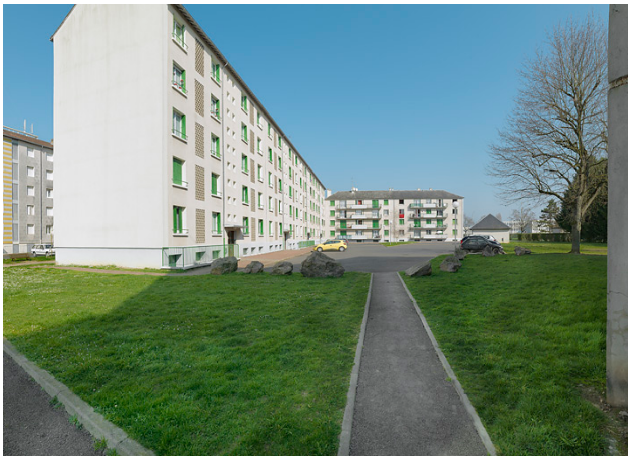
Façade antérieure est et façade postérieure sud.
