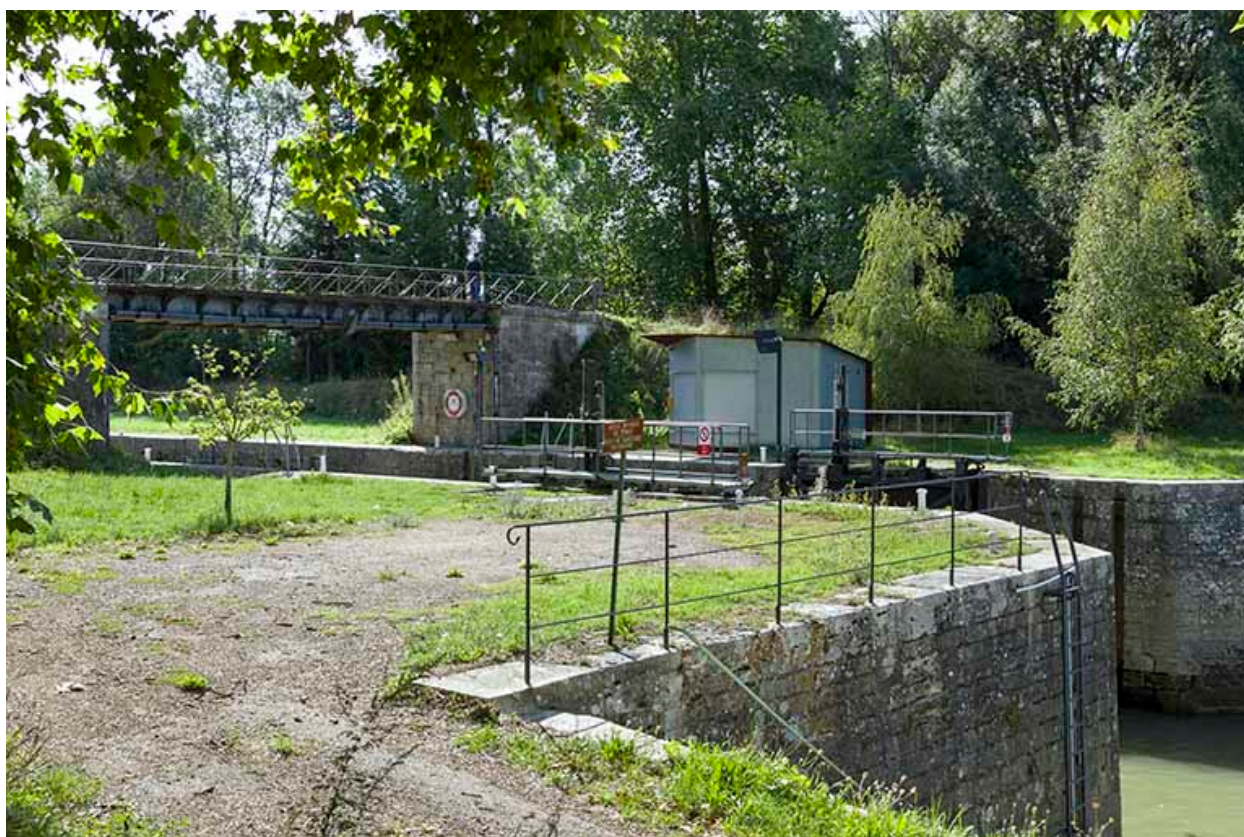
Le poste de commande de l'écluse.
