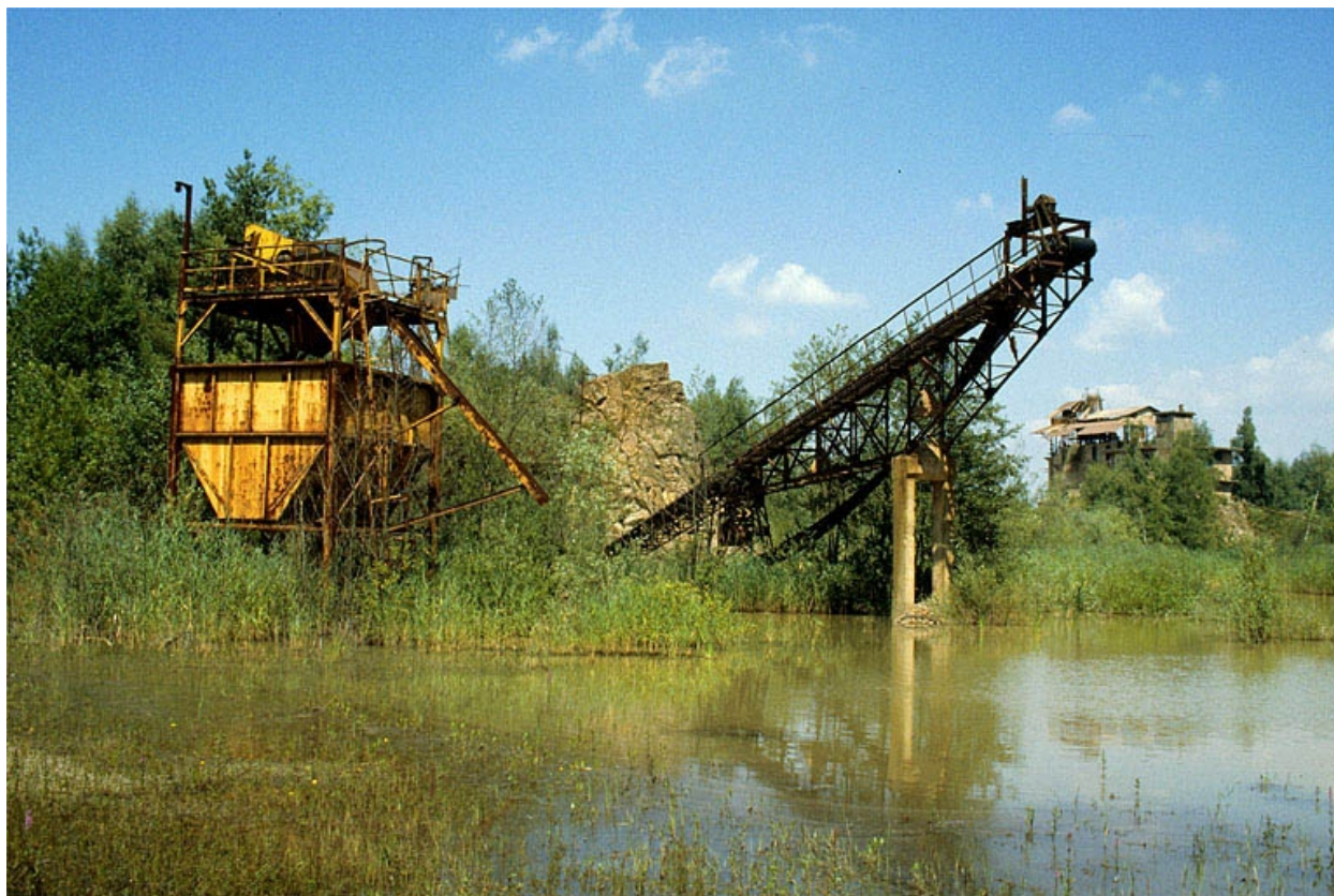
Anciennes installations vues de l'ouest, en 1988.
